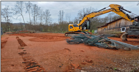
Zäune, Netzpfosten und alte Rabatten sind entfernt
