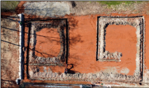
Gräben für Strom- und Datenkabel wurden gezogen
