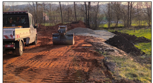
Böschung zum Nachbargrundstück ist angelegt
