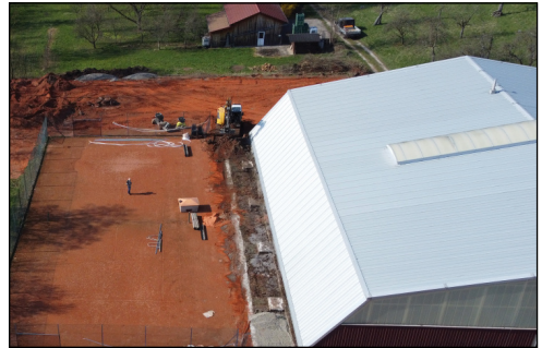
Betonsteine (U-Steine) von altem Podest wurden entfernt und entsorgt
