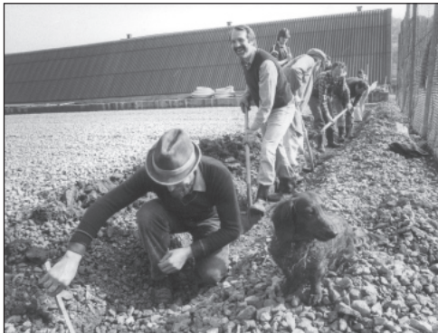
Hier beim Ausheben der Gräben für die Sprenkler
